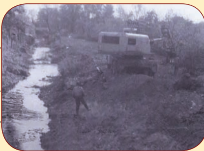
Úprava koryta Farského potoka
