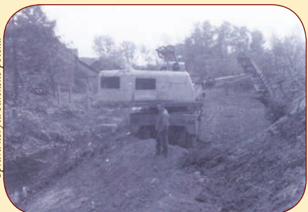
Úprava koryta Farského potoka
